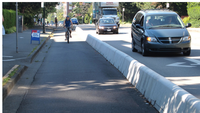
Zone tampon : Bordure de béton, rue Burrard, Vancouver
